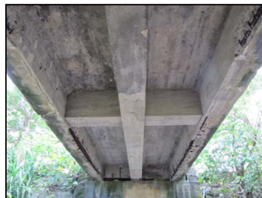
【健全度 20 点未満の橋梁の例】
