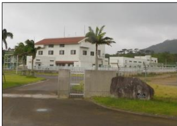
石垣西浄化センター
