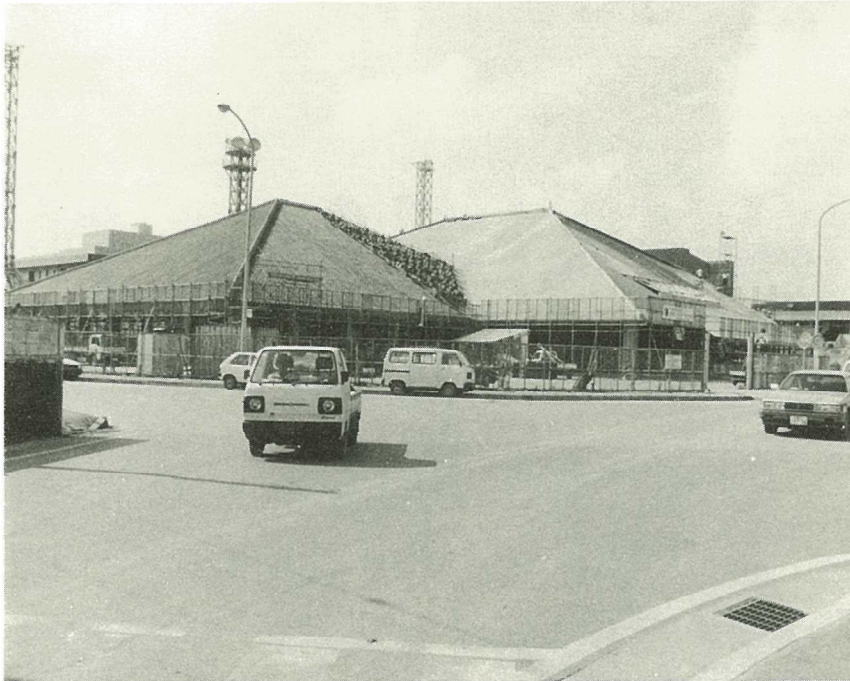
▲赤瓦屋根の一部と周辺緑化を残すのみとなり、着々と工事が進む市立図書館。
