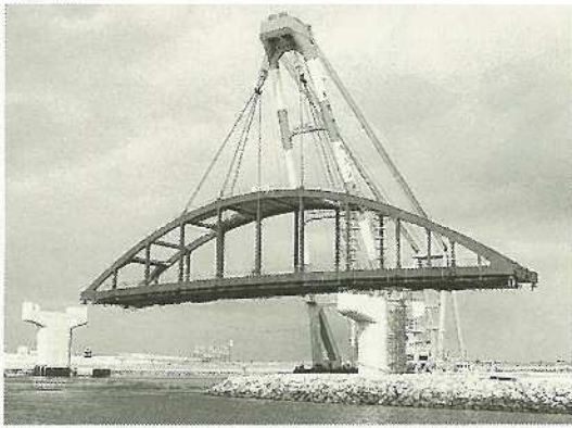
(5/21) 八島町と出島とを結ぶサザンゲートブリッジの主橋部架設
