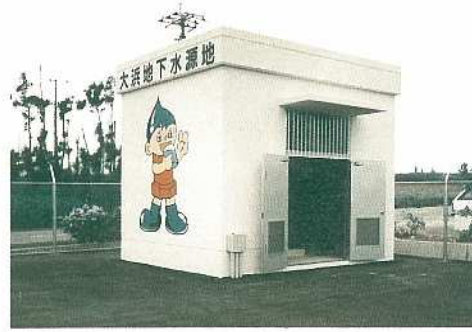
大浜地下水源施設が完成
