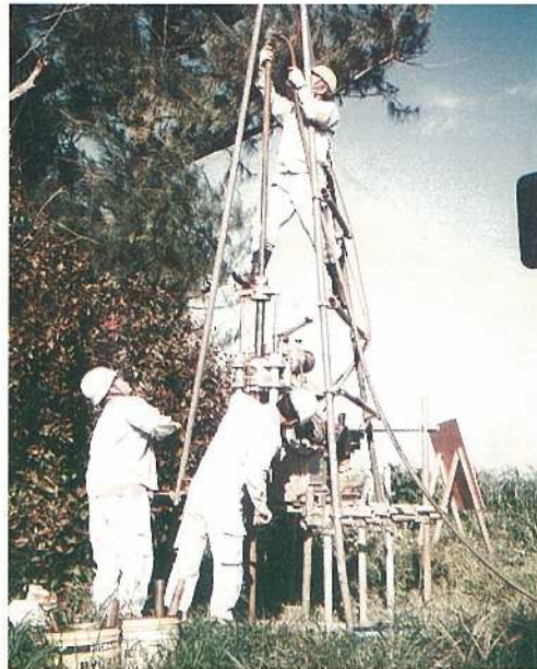
土質調査のためのボーリング作業
