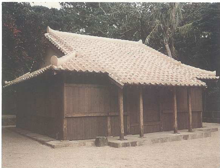
修復が行われた富崎観音堂
