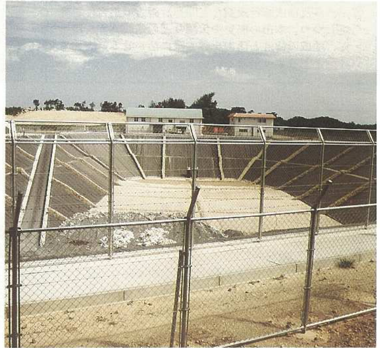
供用開始された最終処分場
