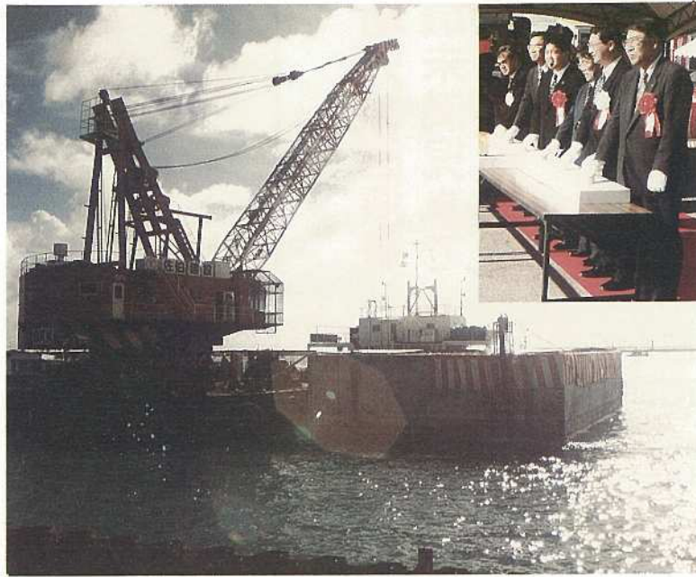
耐震岸壁が建設される石垣港と式典の様
