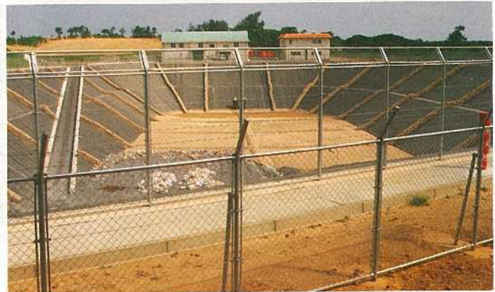
▶一般廃棄物最終処分場が完成しクリンセンター等とともに一体型の処理施設を整備
