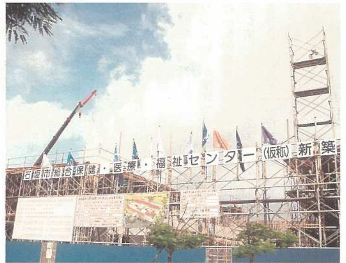
建設が進む保健・医療・福祉センター
