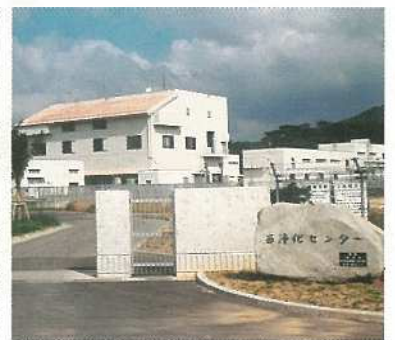
供用を開始した西処理区浄化センター
