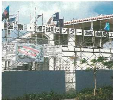
建設された市健康・福祉センター
