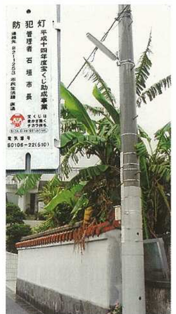
新設された防犯灯
