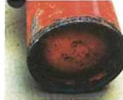
溶接部とその周辺の腐食
