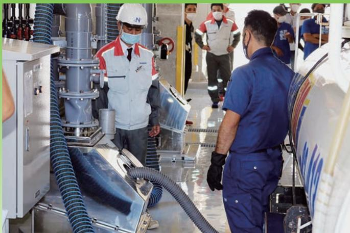
石垣西浄化センターに、し尿受入・汚泥消化施設が増設され5月18日に運用が開始されました。これにより同施設では、公共下水道の汚水処理に加え、バキュームカーにより収集された、し尿や浄化槽汚泥の受け入れが可能となりました。し尿や汚泥は消化・脱水・乾燥などの工程を経て浄化され、処理過程で発生するメタンガスは施設の燃料として利用し、処理後に残る残渣(ざんさ)は、堆肥として農地へ還元されます。このように環境に優しい循環型の施設となっています。
