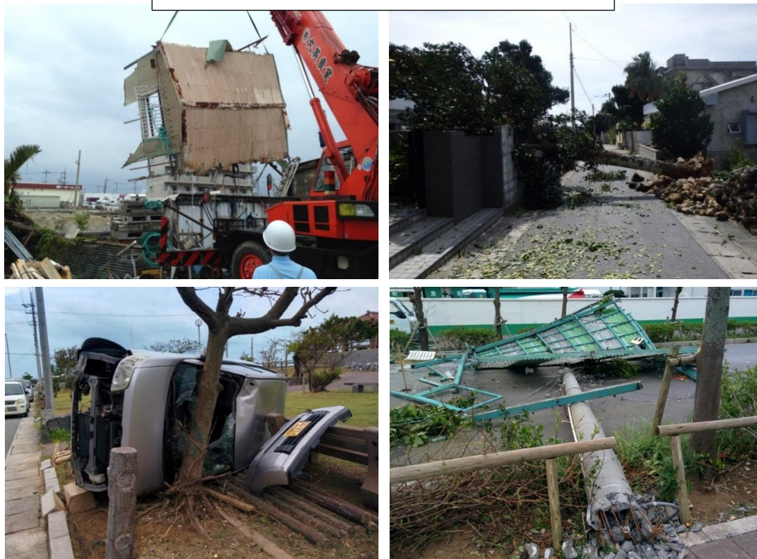
平成27年台風15号による家屋・道路等の被害
