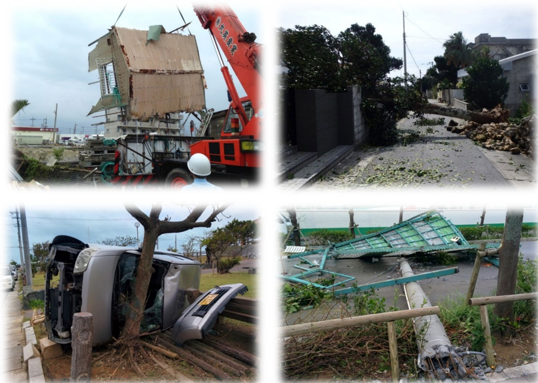
平成27年台風15号による家屋・道路等被害
