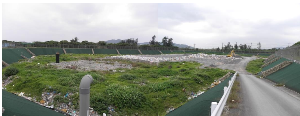
写真 1.5 埋立状況（平成 23 年 3 月撮影）
