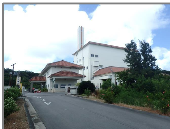
写真 1.1 石垣市クリーンセンターの外観
