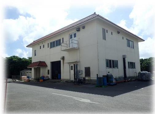
写真 1.3 浸出水処理施設外観
