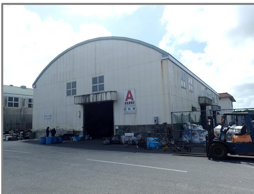
写真 1.8 前処理施設の外観
