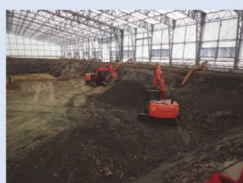
掘起こし作業状況
