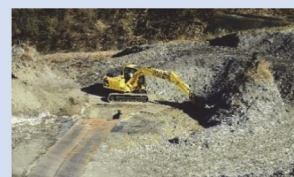
既埋立ごみ掘起こし
