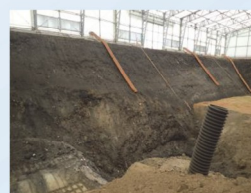
排気用ダクト
