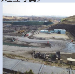
< 民間処分場での埋立写真>
