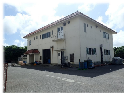
浸出水処理施設外観
