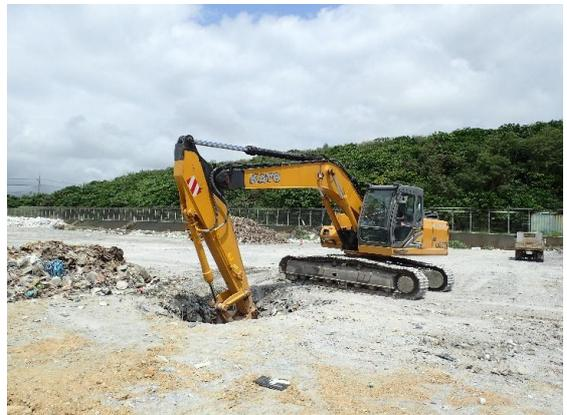
④計量後のフルイ通過ごみを掘削した穴に戻し、転圧する
