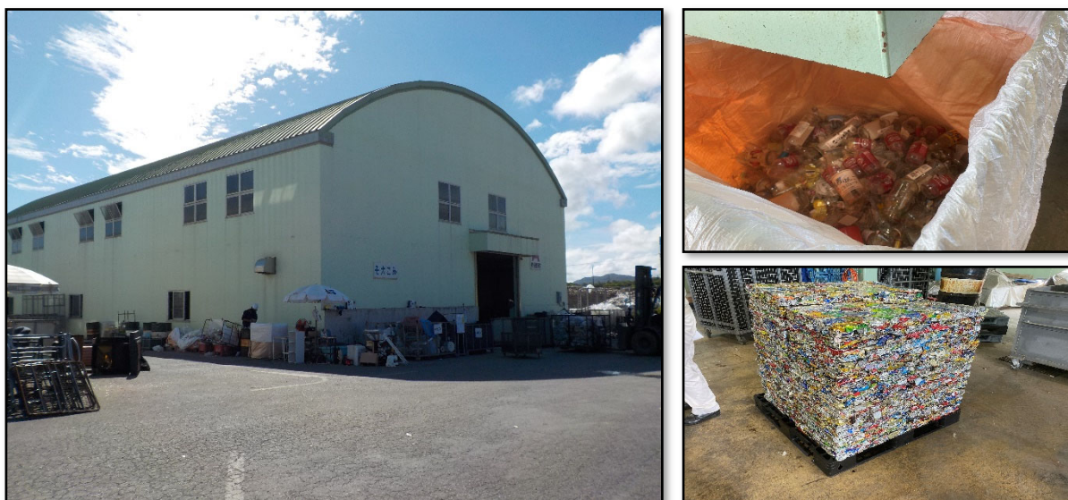
図 2-8 前処理施設の外観
