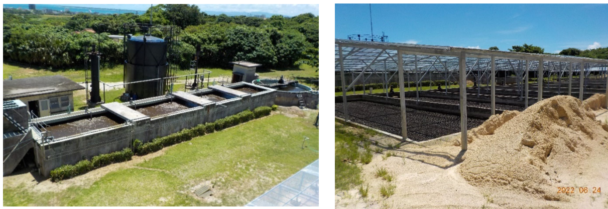
図 4-5 石垣市し尿処理場の外観
