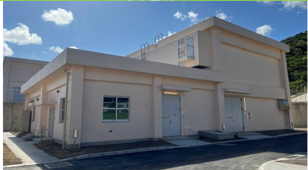
受電所 建物全景
