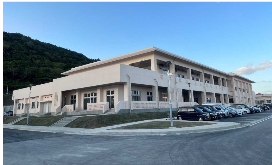
建物全景（食堂棟）
