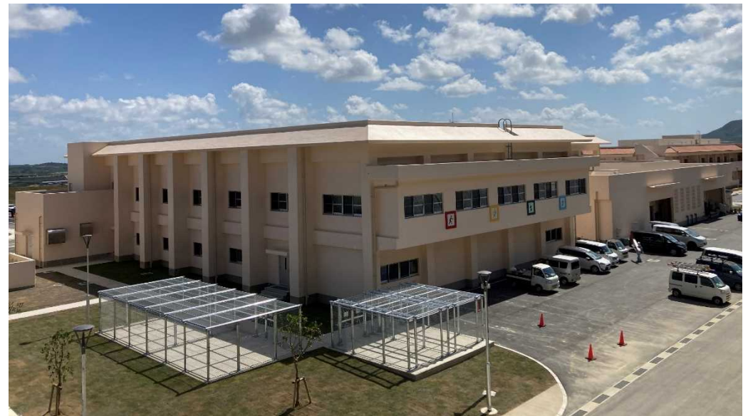
建物全景（体育館棟）
