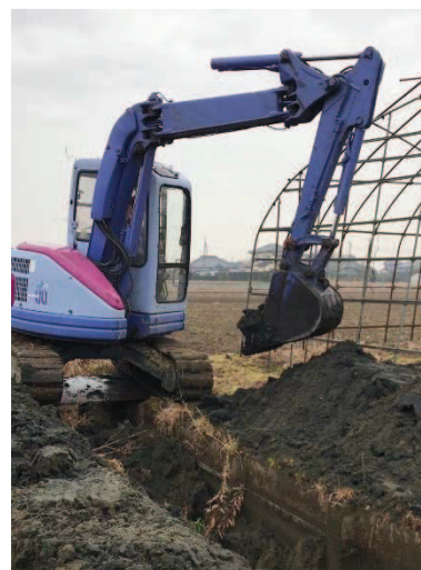
重機による水路の泥上げ (千葉県 Web サイトより)
