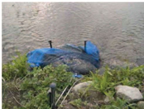
取水口への網の設置 (九州沖縄農業研究センターWeb サイトより)
