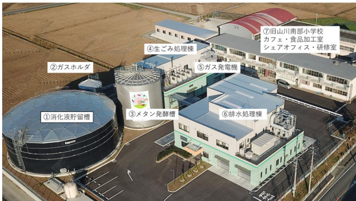
図 2-12-8：みやま市バイオマスセンターの施設配置。①消化液貯留槽（容量 4,000t）②ガスホルダ③メタン発酵槽（生ごみ等を 20 日かけて発酵）④生ごみ処理棟（生ごみを小さく破碎して発酵しやすくする）⑤ガス発電機（25kW の発電機 4 基で施設の電力の 60%をまかなう）⑥排水処理棟（水分の多い浄化槽汚泥を濃縮し、残った水は処理し浄化槽の張り水として再利用）⑦旧山川南部小学校校舎（出典：みやま市） （みやま市提供写真を加工して作成）
