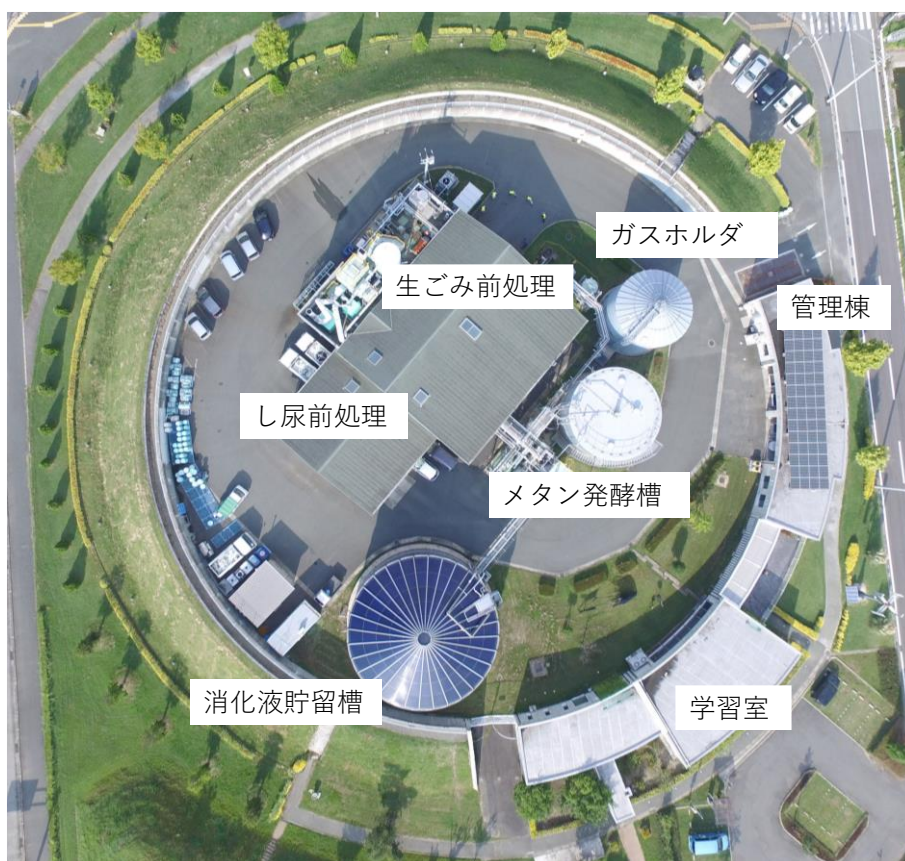
図 2-12-1：大木町におけるバイオマスセンター（Google Earth を加工して作成）
