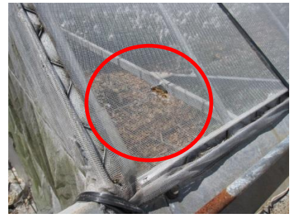
ネット等の破れの補修
