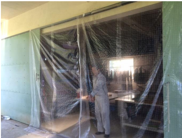
集荷場入口のネット設置
