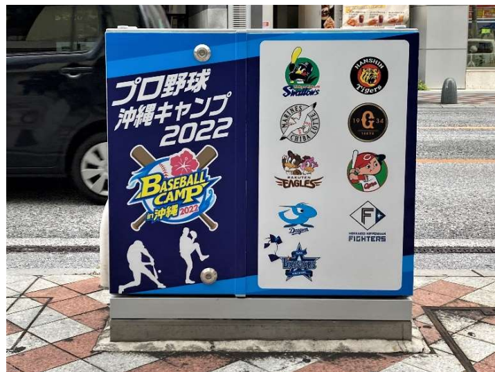
ラッピング施工後
