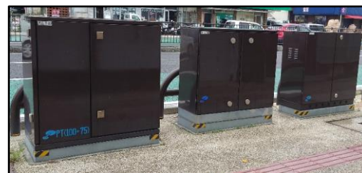
画像：電線共同溝方式による無電柱化 宜野湾市内設置 地上機器
