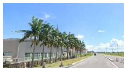
県道石垣空港線の緑化 (空港跡地での施工中)
