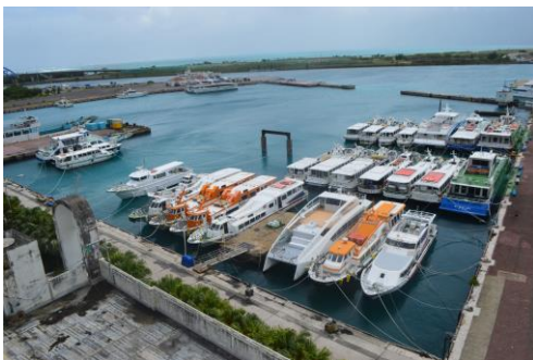
台風時の高速船の係留状況 (令和4年9月台風11号)
