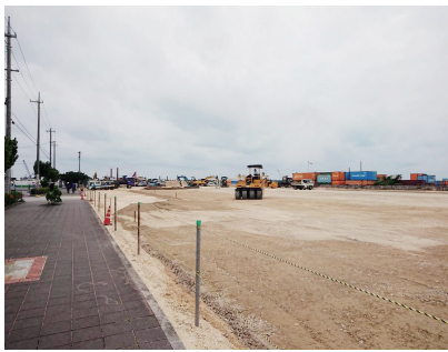
5月一部供用を目指し、駐車場の整備が進められている(株)りゅうせき跡地
