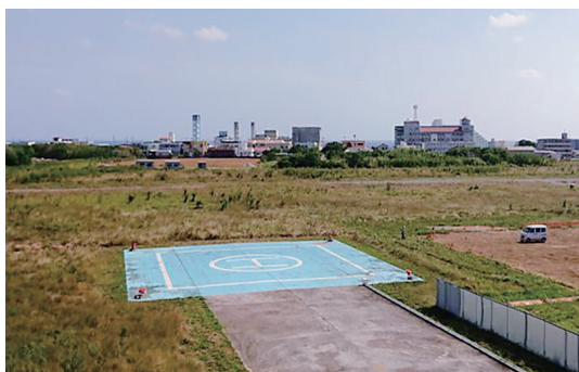
継続使用が困難視されている現ヘリポート
