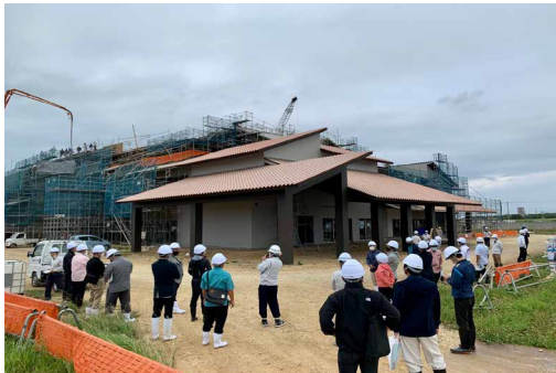
3常任委員会合同で視察した新庁舎建設現場
