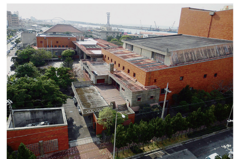
開館後約30年が経過し、施設や設備に老朽化が見られる市民会館
