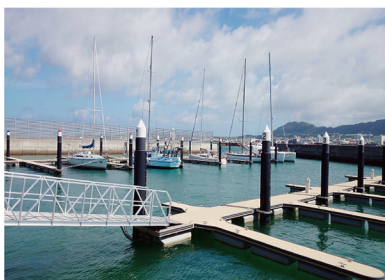
石垣漁港内に整備されたフィッシュリーナ写真の浮棧橋の外に駐艇場有り
