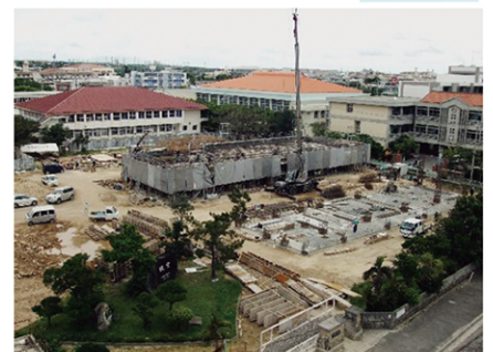
平成29年度4月に供用開始予定で工事が進められている登野城小学校
