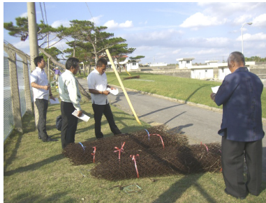
浄水場を囲むフェンスの補修状況を確認（建設土木委員会）
