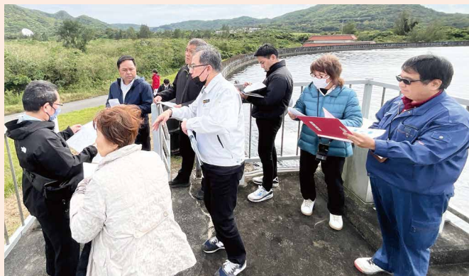
白水原水調整池を視察する建設土木委員会の皆さま
