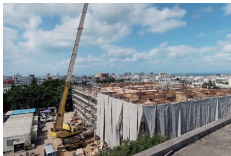
石垣小学校校舎新增改築工事の様子
