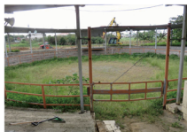
すでに改修工事が進められている 八重山開牛場
