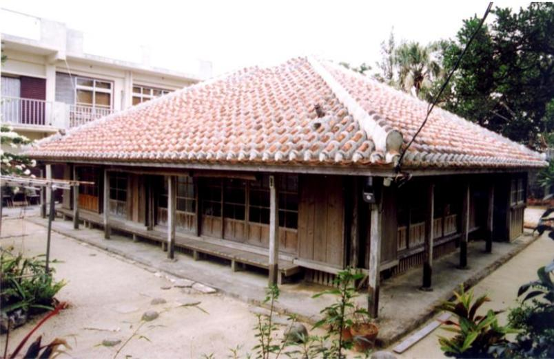
入嵩西住宅が所在する一帯は字新川のマフタネーと呼ばれる地域で、伝統的な農家の屋敷構えや建物配置などが残っている。住宅主屋は、1911(明治44)年頃に赤瓦葺きで建てられたと伝えられ、建築材はイヌマキ、モッコク、フクギなど島産の高級木材が用いられている。建築主は篤農家で主屋は部屋数も多く、特に台所は広く作られている。1955(昭和30)年には、台所の土間を板張りにするなど一部改修されているが、ほとんど建築当初の原形を残している。
