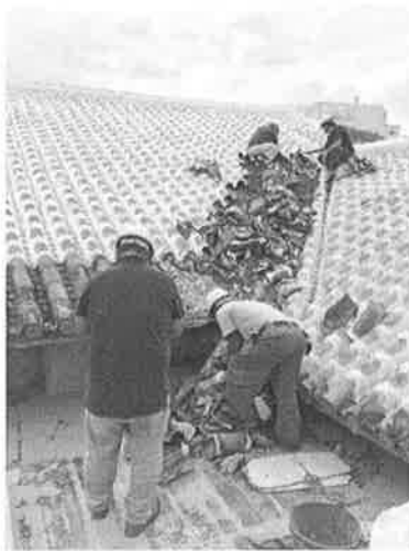
雨漏り防水工事の様子
