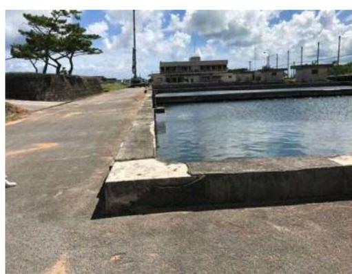
【緩速ろ過池 モルタルコンクリート剥がれ】
