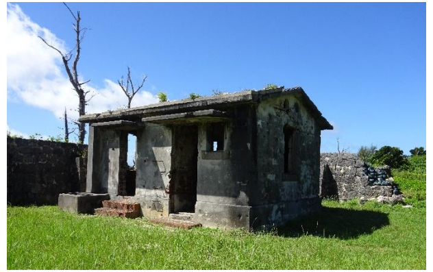
海底電線陸揚室跡(電信屋)
