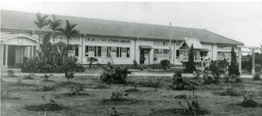
沖縄県立八重山農学校校舎(1938(昭和 13)年頃) 八重山写真帖より
