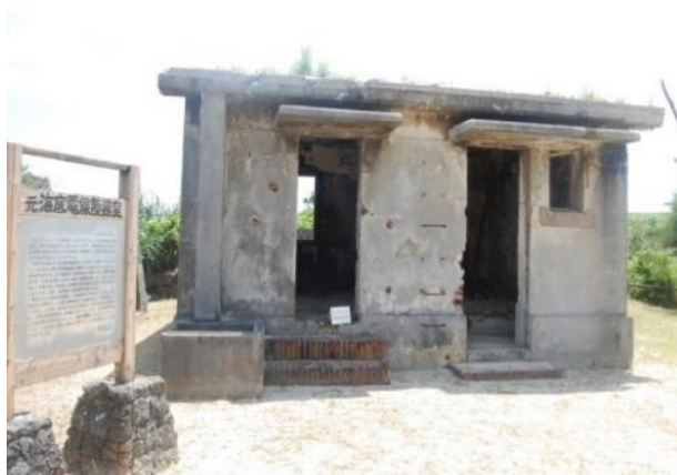
海底電線陸揚室跡(電信屋)
