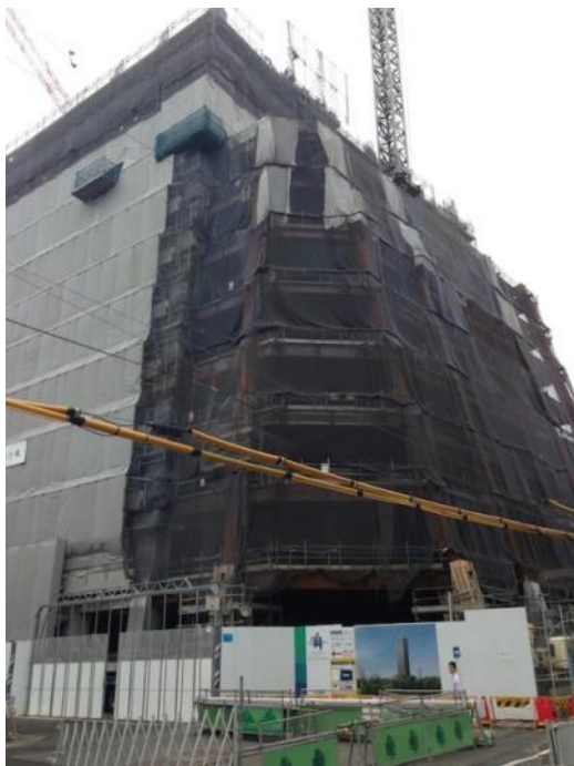
新庁舎建設現場
