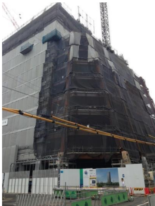
新庁舎建設現場
