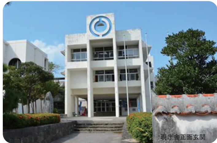
現庁舎正面玄関
