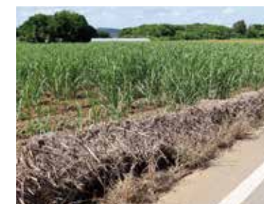
葉ガラ梱包の設置による 赤土流出対策
